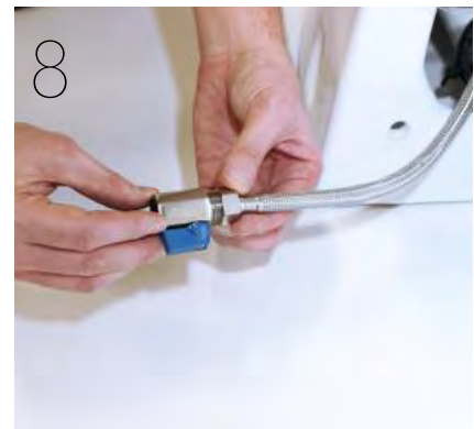
8 The very last step of the installation is connection the water. Test-flush the WC before first usage. Det allra sista steget i installationen är att ansluta vattnet. Test-spola WCn innan första användning.
